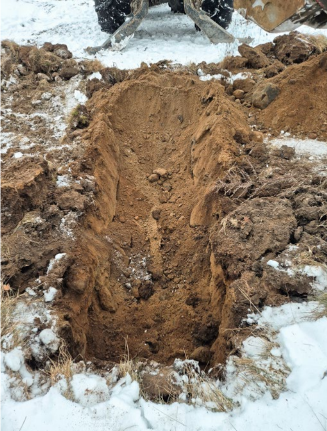
Figur 5. Schakt 200 grävt för ny stolpe, 2 meter djupt. Mot S. (Fotonummer: 2026-17-5). Foto: Mats Nilsson.
